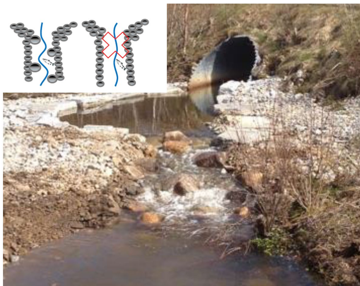
Figur 9. Eksempel på kulp nedstrøms kulvert, og rampe som gjør det mulig for fisk å svømme inn i kulverten. Bildet og illustrasjon er hentet fra Statens vegvesens rapport nr. 459 – Frie fiskeveger [12].
